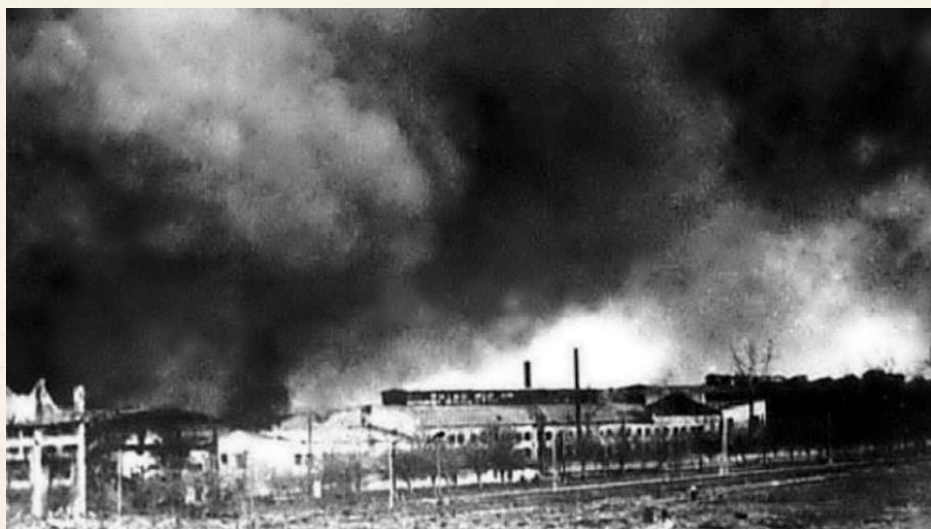
Пожар в колесном цехе Горьковского автомобильного завода после бомбардировки, 1943 год
